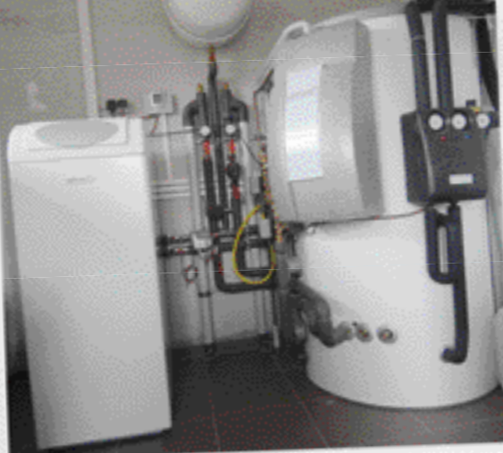
Wartungsfreundlich und platzsparend: Die gesamte Anlage wurde im Hauswirtschaftsraum untergebracht.
