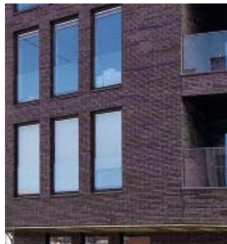
/ Die rahmenintegrierten gläsernen Absturzsicherungen vor den bodentiefen Fenstern sind fast unsichtbar.
