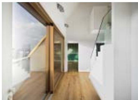
/ Die vier Terrassen der Maisonettewohnung werden über Hebe-Schiebe-Türen erschlossen. (Foto: Runge)
