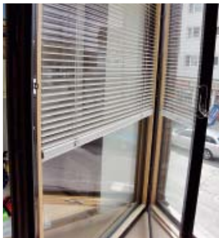
/ Die äußere Scheibe lässt sich öffnen, sodass ein Zugang zum Sonnenschutz möglich ist. (Foto: Autorin)
