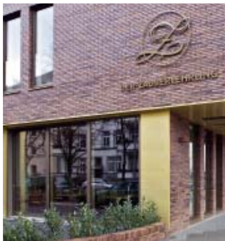
/ Eine dreiteilige Hebe-Schiebe-Türanlage verbindet das Restaurant mit der Außenterrasse. (Foto: Runge)
