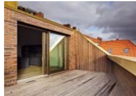
/ Die Deckschale der Fenster ist passend zum Dach in bronzefarben eloxiertem Aluminium. (Foto: Runge)
