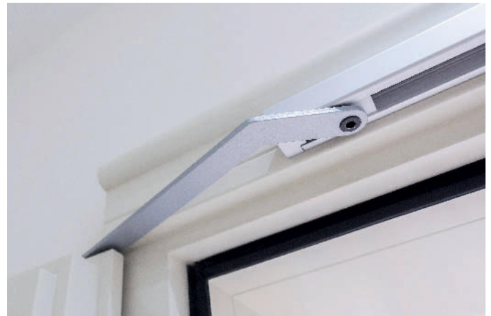
/ Bei der 180°-Öffnung war aufgrund der Dekorprofile ein Standardbeschlag nicht möglich. Die Lösung: ein Sonderbeschlag mit abgekröpftem Hebelarm.
