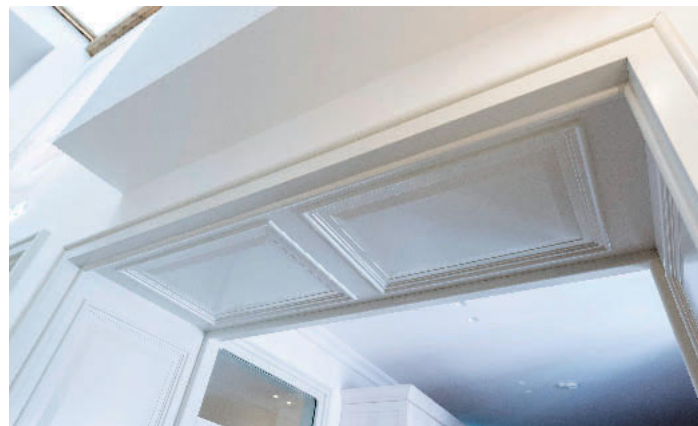
/ Für ein einheitliches Erscheinungsbild fertigte Dibra das Durchgangsfutter passend zu den Türelementen im selben Dekor nach historischer Bauart.
