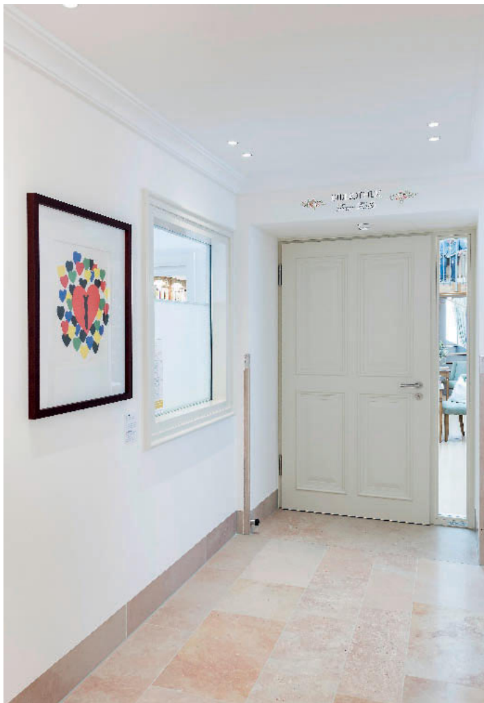
/ Der Brandschutz erstreckte sich neben den Türen auch auf das feststehende Seitenteil sowie das Fensterelement als T30-Verglasung.
