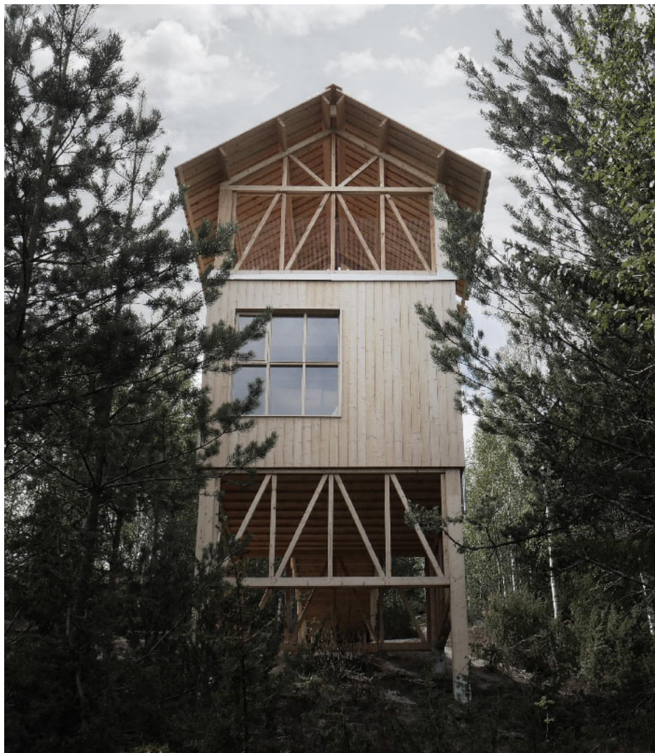
Die aufgeständerte Konstruktion auf Stelzen machte nur wenige punktuelle Eingriffe in das harte Felsgestein des Berghangs notwendig, so blieb die Natur weitgehend unberührt.
