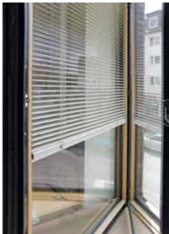
Die thermische Verglasung innerhalb des Verbundflügels des Fensters Slimline Cv-79 lässt sich öffnen, so dass die Sonnenschutzlamellen einfach zu erreichen sind
