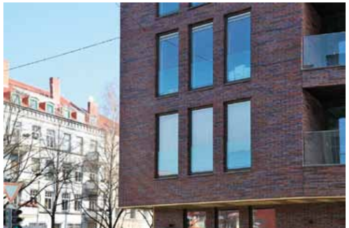
Die rahmenintegrierten gläsernen Absturzsicherungen vor den bodentiefen Fenstern sind innerhalb der Fassade fast unsichtbar Foto: Markus Becker
