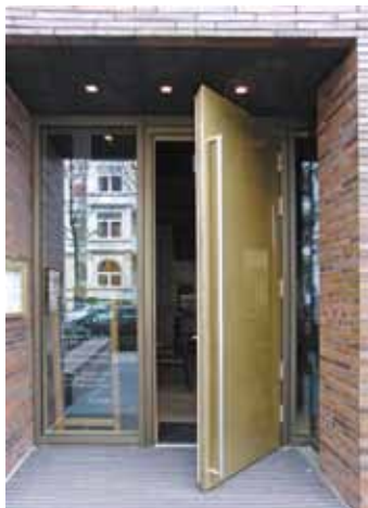
Die Eingangstür zum Restaurant wurde von Holzbau Becker & Sohn gefertigt und von einem örtlichen Unternehmen mit Messingblech bezogen Fotos (2): Katharina Ricklefs
