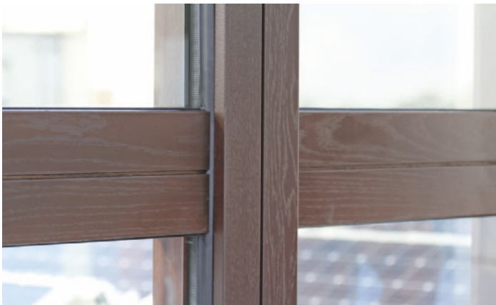
/ Die neuen Fensterkonstruktionen sind aus Eiche und erhielten eine zeitgemäße Mehrfachverglasung für einen effizienten Wärmeschutz.
