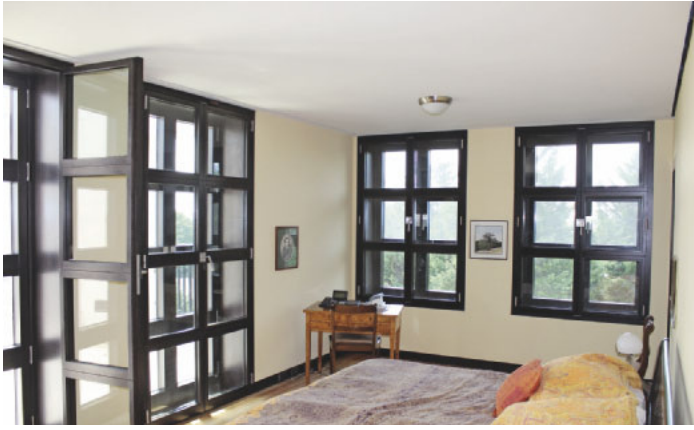
/ Rund 20 % der Kastenfenster wurden vor Ort entsprechend der von Hans Timm mit entwickelten Richtlinie denkmalgerecht saniert.
