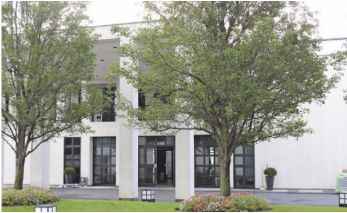
/ Innerhalb der Fassade findet sich das stilistische Element des Quadrats auch bei den Fenster- und Türkonstruktionen wieder.
