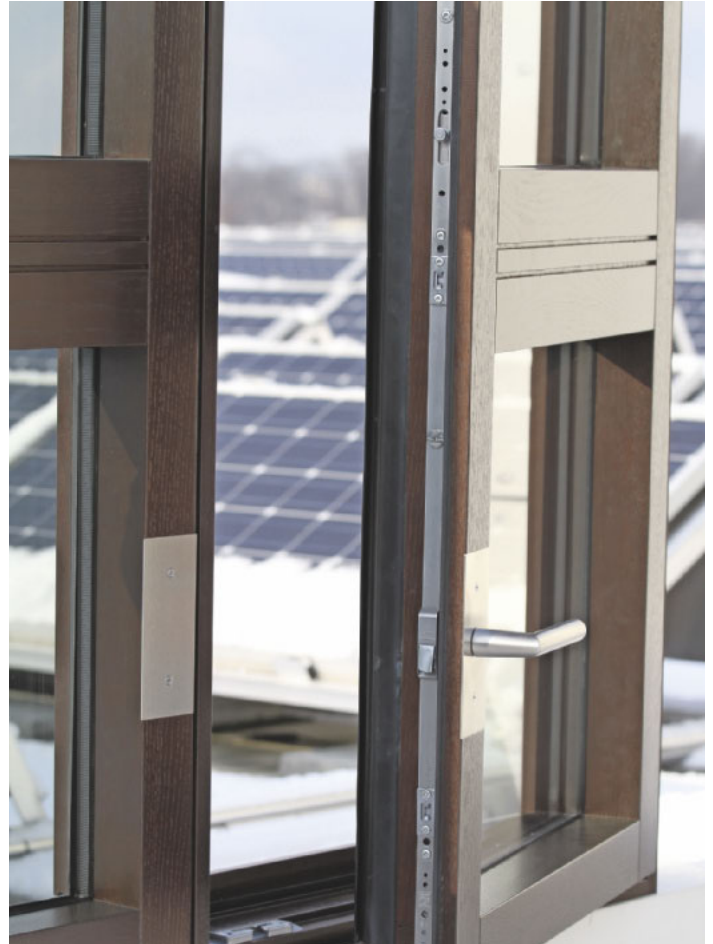
/ Die ca. 70 neuen Holzfenster wurden als Holz-Holz-Integralkonstruktionen nach dem Aufmaßtermin in nur acht Wochen in Berlin gefertigt.
