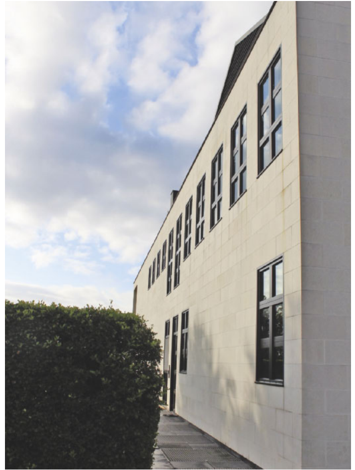
/ Im Klima Washingtons sorgt eine Anti-Heat-Beschichtung auf den schwarz lasierten Fensterelementen der Fassade für eine längere Haltbarkeit.
