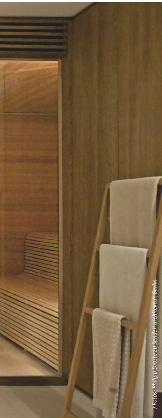
/ Die schwebende Anmutung der auskragenden Liegebank an der Wand ermöglichen vier konstruktiv mit der Rückwand verankerte Stahlkonsolen.
